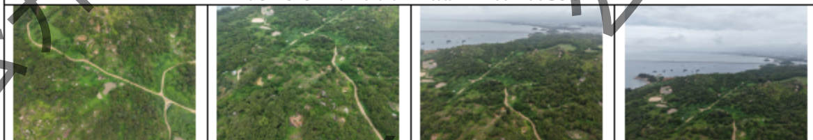
广澳纵一路、广澳横二路沿线现状
