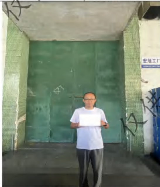
工程师现场踏勘照片
