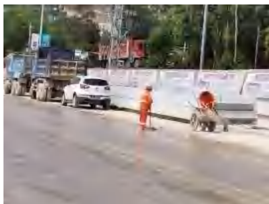
图 5.1-3b 施工期现场道路清扫
