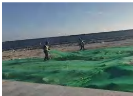
图 5.1-4b 裸土绿网覆盖
