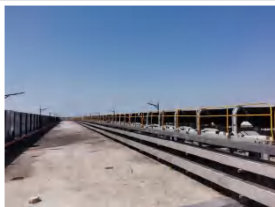
高架栈桥两侧挡风板
