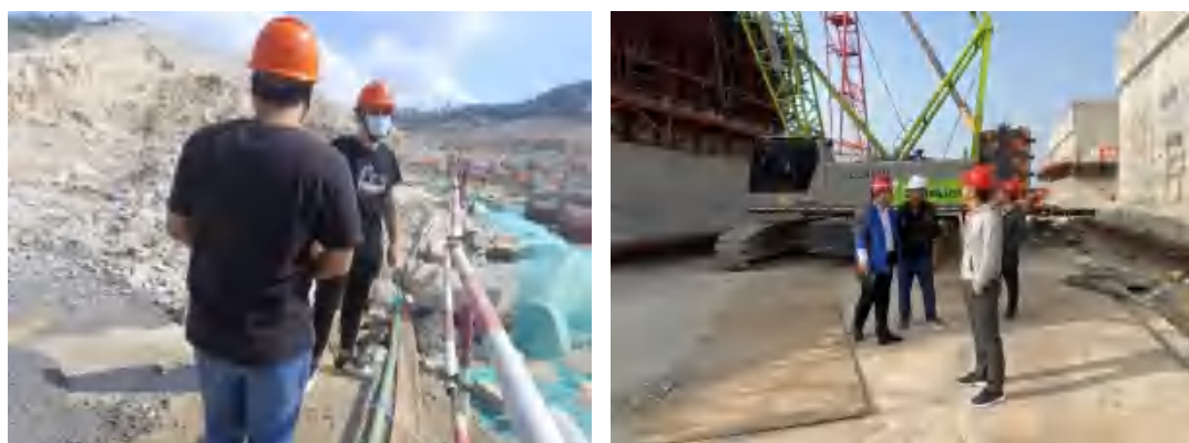
图 10.1.2-1 监理单位巡视现场
