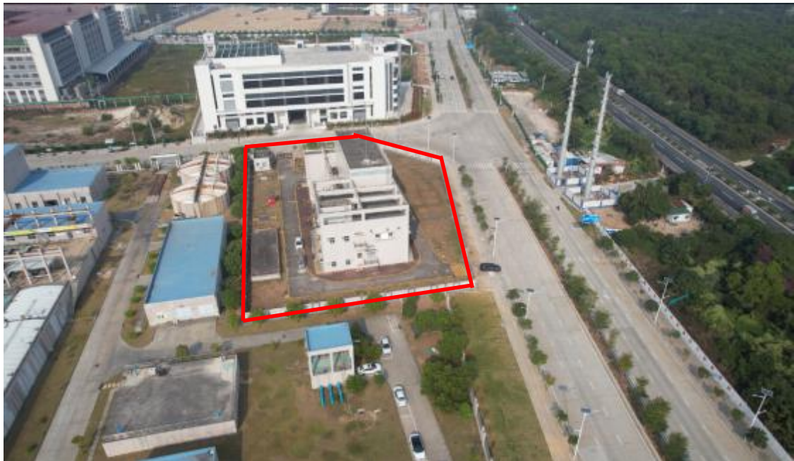
图 2-9 110 千伏双山站址现状照片
