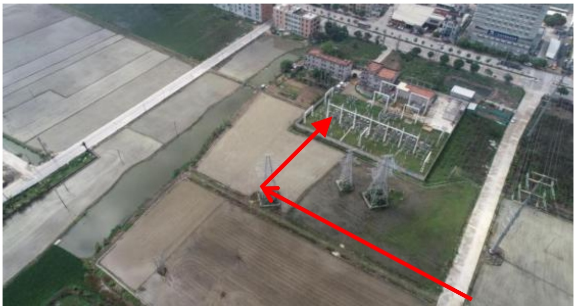
图 2-7 线路接入 110kV 沙陇站周边情况图
