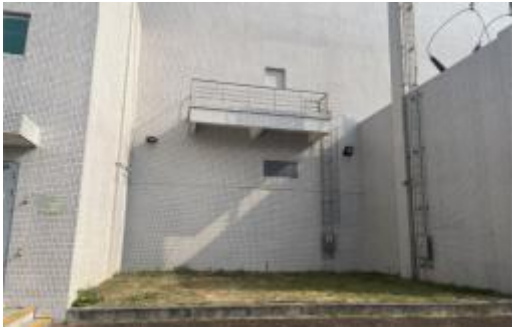
扩建 3#主变预留场地（63MVA）
