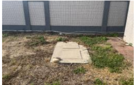
双山站内化粪池
