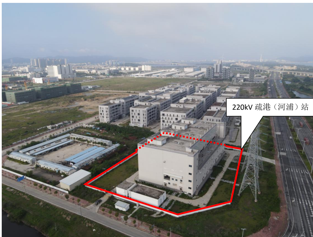
图 2-1 220kV 疏港(河浦)站现状照片
