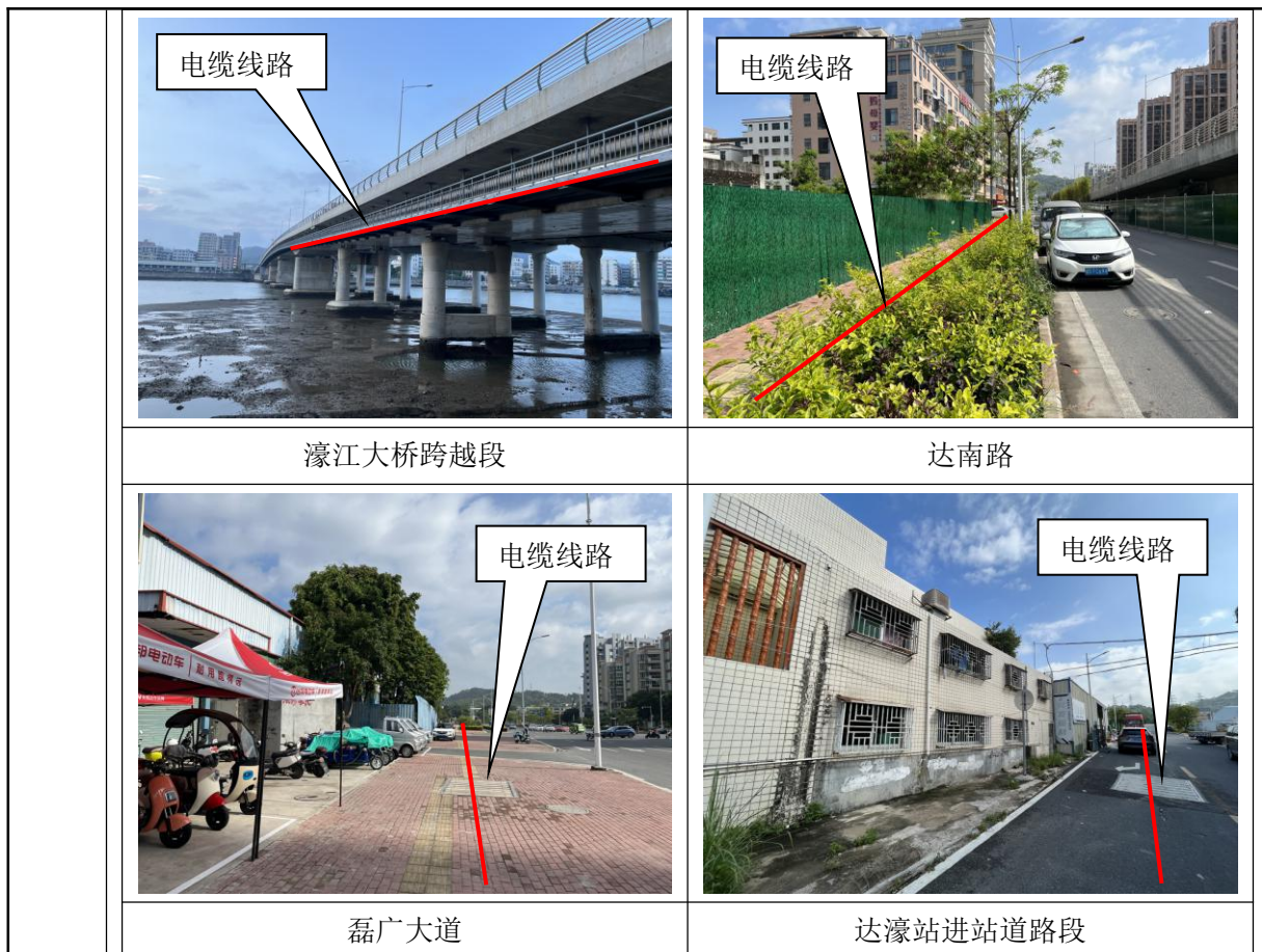
图 2-2 110kV 电缆线路沿线现状照片
