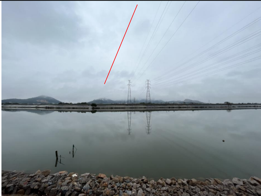
图 2-4 线路跨越南溪河现场照片
