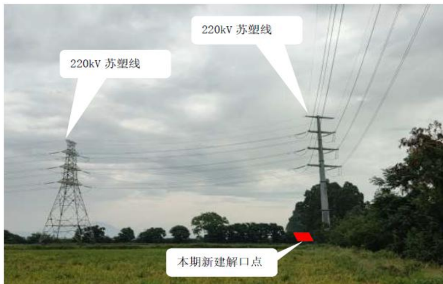
图 2-7 220kV 苏塑线解口点现场照片
