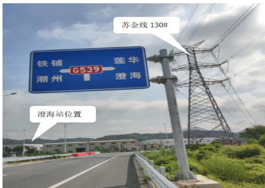
图 2-5 苏南侧跨越 G539 国道现场照片
