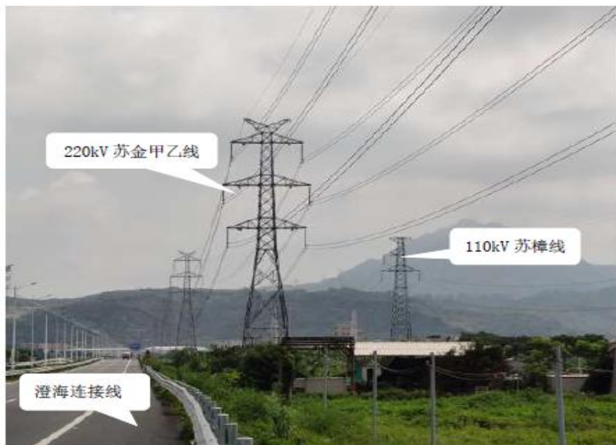
图 2-3 新建四回线路行现场照片
