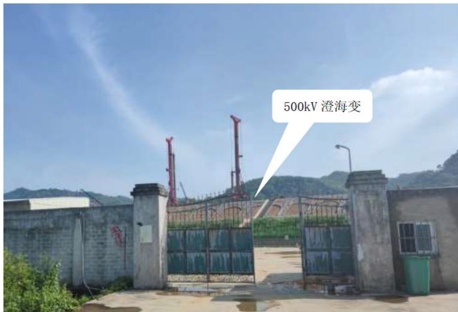
图 2-2 500kV 澄海站（正在施工）现场照片
