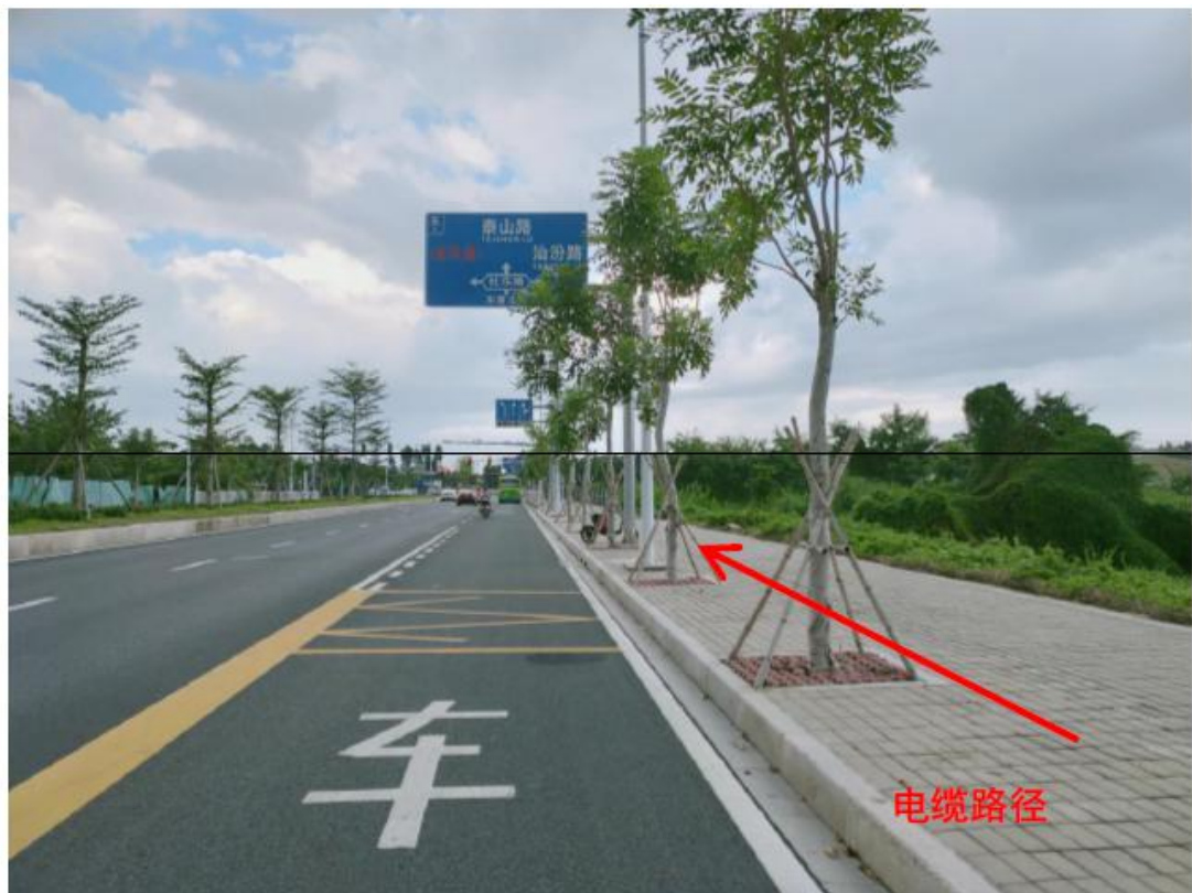
图 2-3 路径现状图②（东厦北路）
