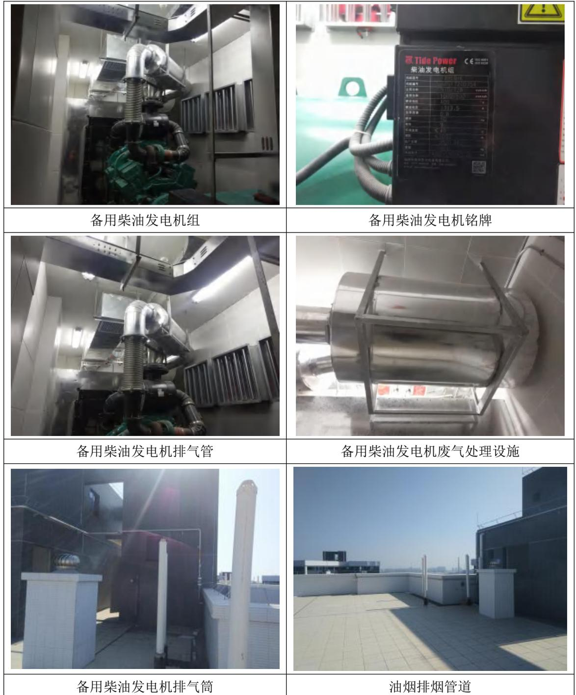
图 3-1 项目备用柴油发电机组及其排气筒设置情况、项目油烟废气排气筒
